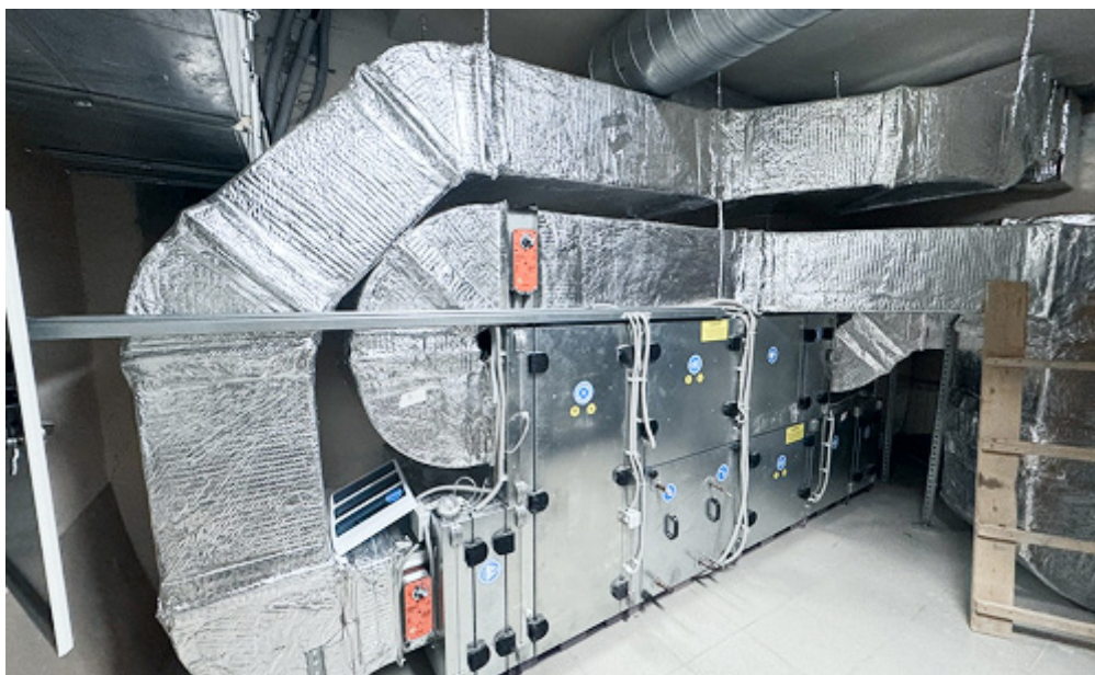
Рисунок 1. Вентиляционная установка ROTADO
